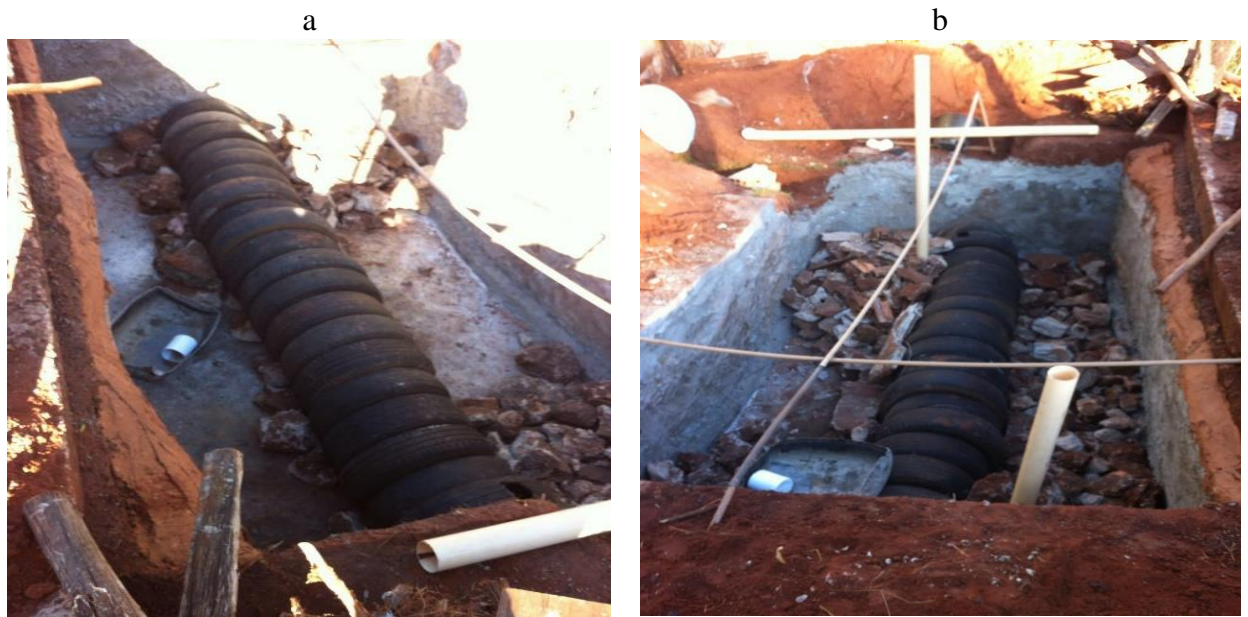
Figura 3. Câmara de recepção do tanque de evapotranspiração. (Fonte: Autor)
