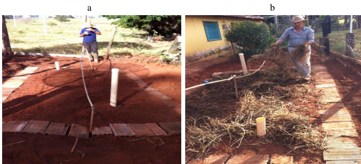
Figura 5. Camada de solo (a); Tanque de evapotranspiração finalizado (b). (Fonte: Autor)
